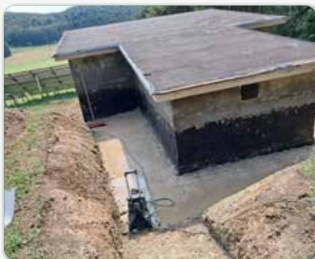
gend saniert werden. Es wurde rundherum ausgegraben und von unten her abgedichtet, Drainage und Schotter verlegt und einige Risse fachgerecht repariert. Kosten rund 37.000,- Euro. Als nächstes steht der Behälter Vorauhof an sanieret zu werden. Dieser ist über 50 Jahre alt und die Arbeiten an dem Behälter sind etwas umfangreicher. Hier werden Kosten von rund 770.000,- Euro auf uns zukommen.
