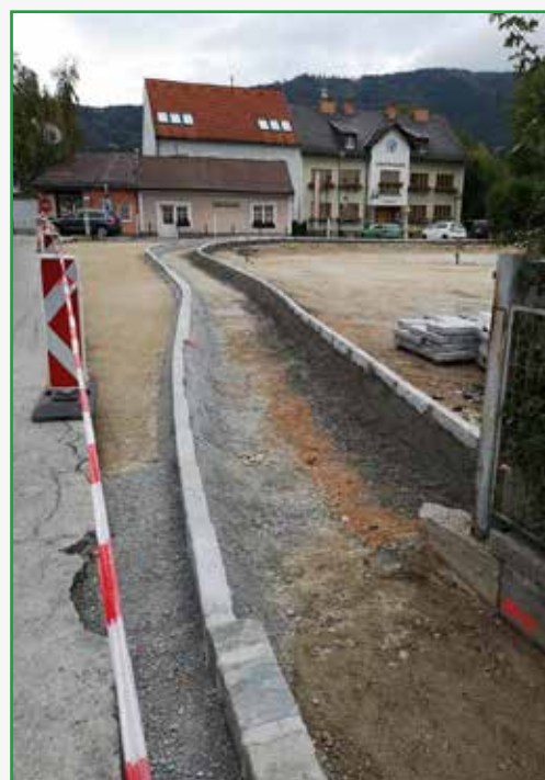
Bau der Abbiegung nach Schratzenbach
