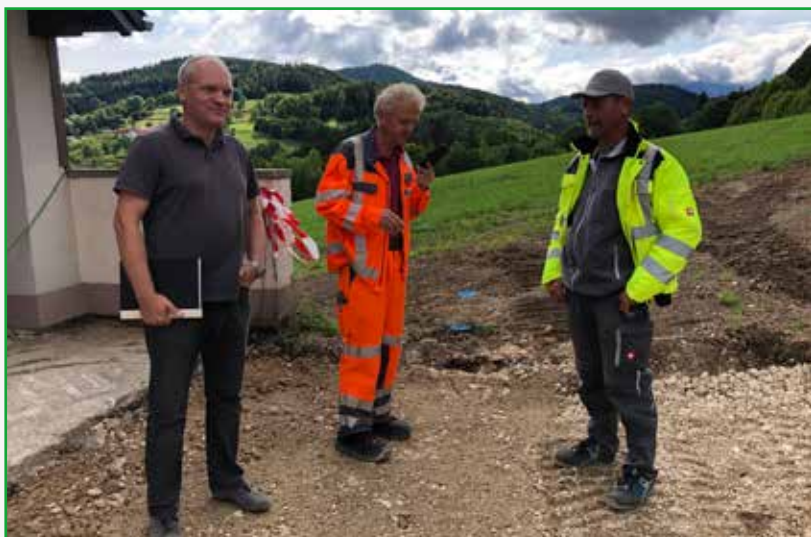
Strassenbau Steigerweg. Bauaufsicht DI Haider, Johann Imnitzer und Polier von Pusion
